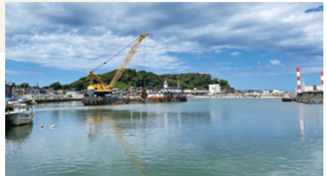
輪島港の隆起した海底を掘る作業はさらに2か月続きました
